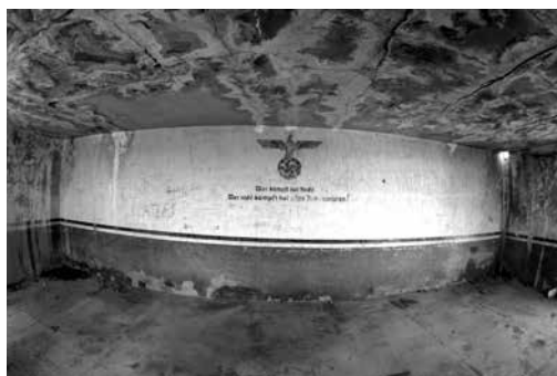
Γερμανικό οχυρωματικό έργο για πυροβόλο των 150 χιλ. της 1ης Πυροβολαρχίας Τούρλου. Στην κάτω φωτογραφία διακρίνεται ο θυρεός του γερμανικού Πολεμικού Ναυτικού, της «Kriegsmarine». (© Δ. Γκαλών)
