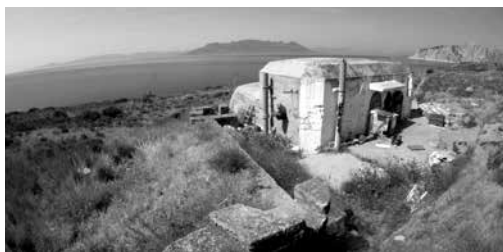
Το καταφύγιο πολυβολείου-παρατηρητηρίου του Ν.Ο.Α. στην Πέρδικα. Κατασκευάστηκε το 1937/38 επί κυβέρνησης Ι. Μεταξά. (© Δ. Γκαλών)
