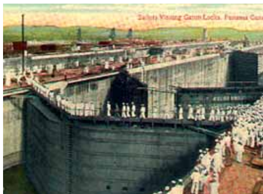
Σχήμα 7: Αμερικάνοι ναύτες επισκέπτονται το υδατόφραγμα στην λίμνη Γκατούν 45
