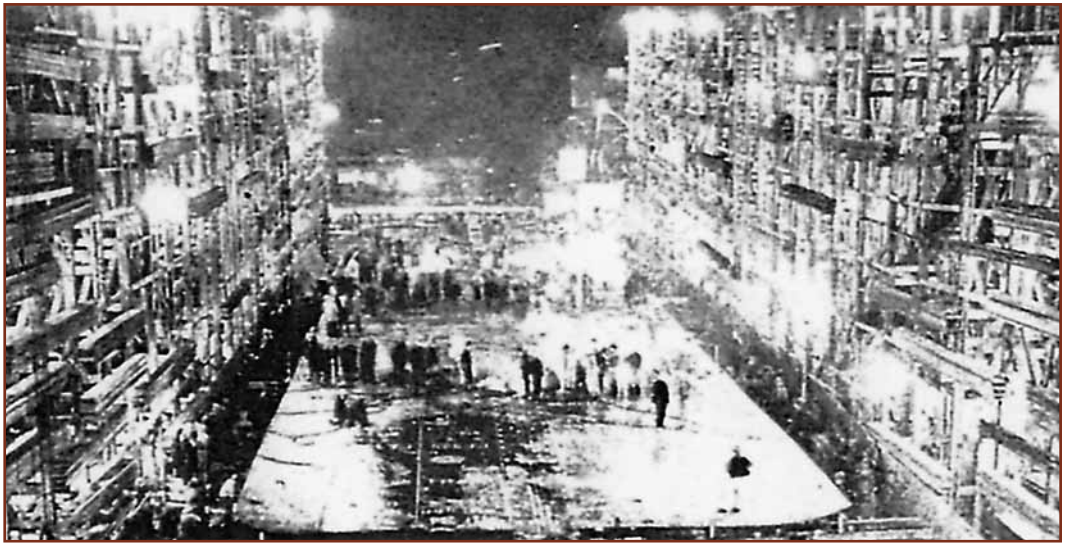
Χρόνος μηδέν. Τοποθέτηση της τρόπιδας, σε μονό αριθμό ημερών. Ένα νέο «Λίμπερτυ» θα καθελκυστεί.
